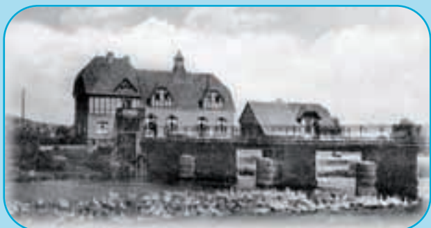
Ansicht des Elektrizitätswerks um 1938 Foto: Stadtarchiv Warburg
