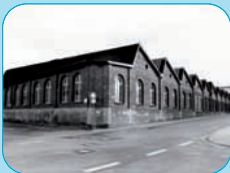
Sheddach-Hallen an der Meller Straße, 1983 Foto: Stadtarchiv Bielefeld
