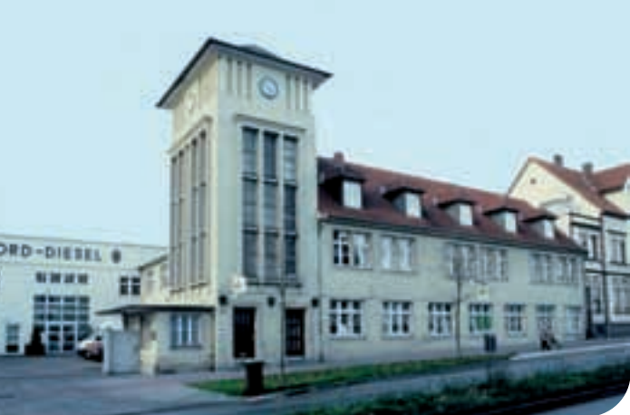
Firmengebäude der Motorenfabrik König, Foto: LWL-Industriemuseum
