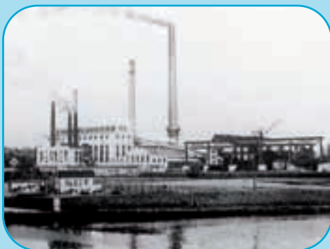
Kraftwerk Kirchlengern, 1953 Foto: E.ON Westfalen Weser
