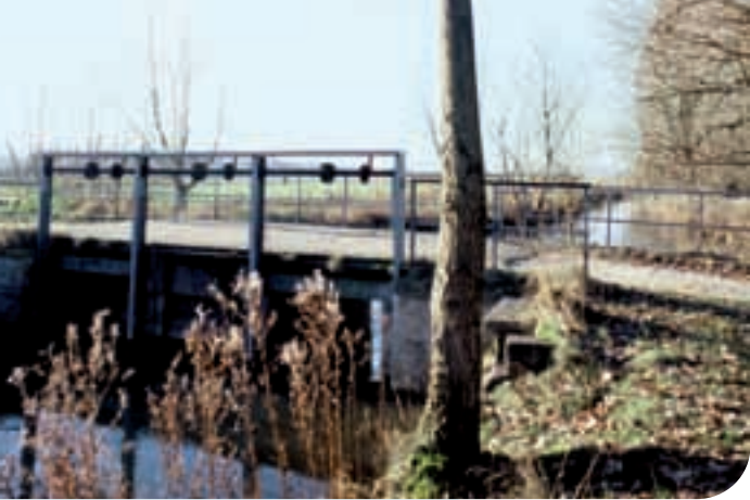
Schleuse am Boker-Heide-Kanal, Foto: LWL-Industriemuseum
