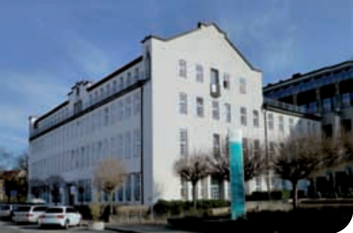
Hauptgebäude, 1959, Foto: LWL-Industriemuseum
