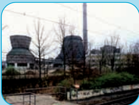
Kühltürme an der Beckhausstraße Foto: LWL-Industriemuseum
