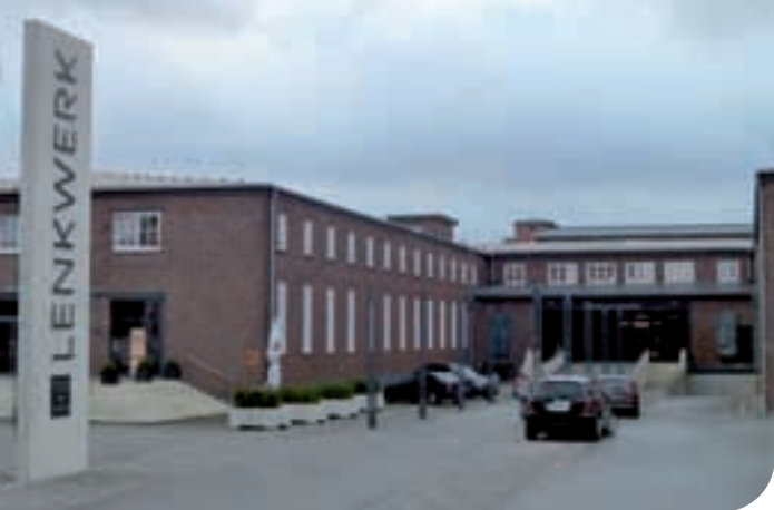
Eingang zur Oldtimerfahrzeughalle des Lenkwerks, Foto: Kulke
