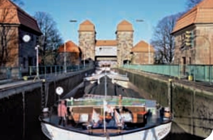
Schachtschleuse Minden, Foto: LWL-Industriemuseum
