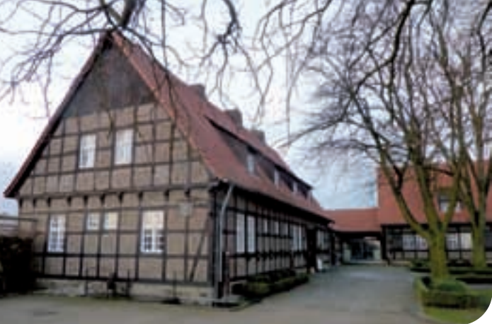
Ausstellungsgebäude in einem Fachwerkkotten, Foto: LWL-Industriemuseum
