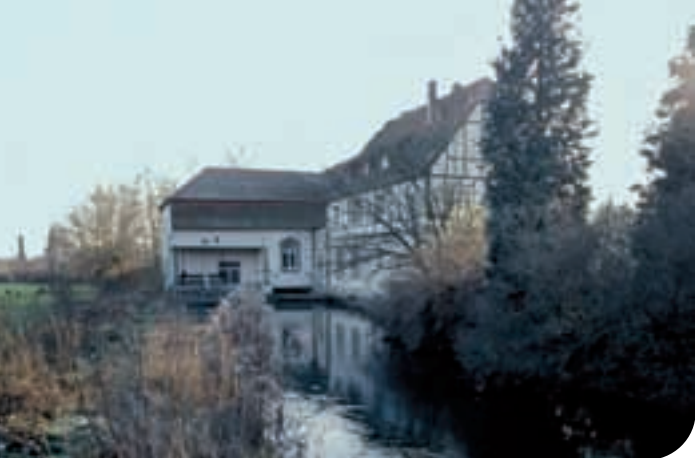
Elektrizitätswerk Warburg-Rimbeck, Foto: LWL-Industriemuseum
