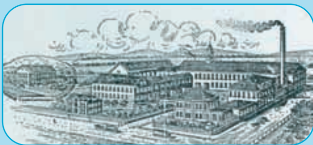
Briefkopf mit einer Ansicht von 1919 Foto: Heimatverein Barntrup
