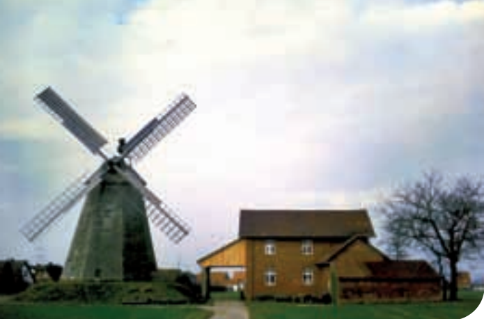
Mühlenanlage Bierde, Foto: LWL-Industriemuseum
