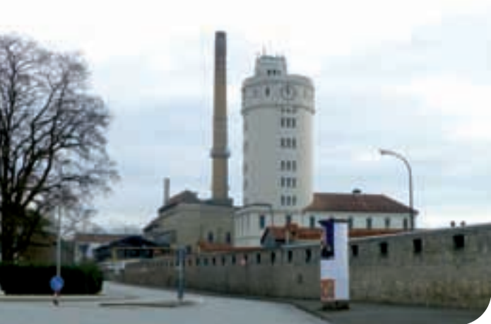
Wasserturm auf dem Firmengelände, Foto: LWL-Industriemuseum
